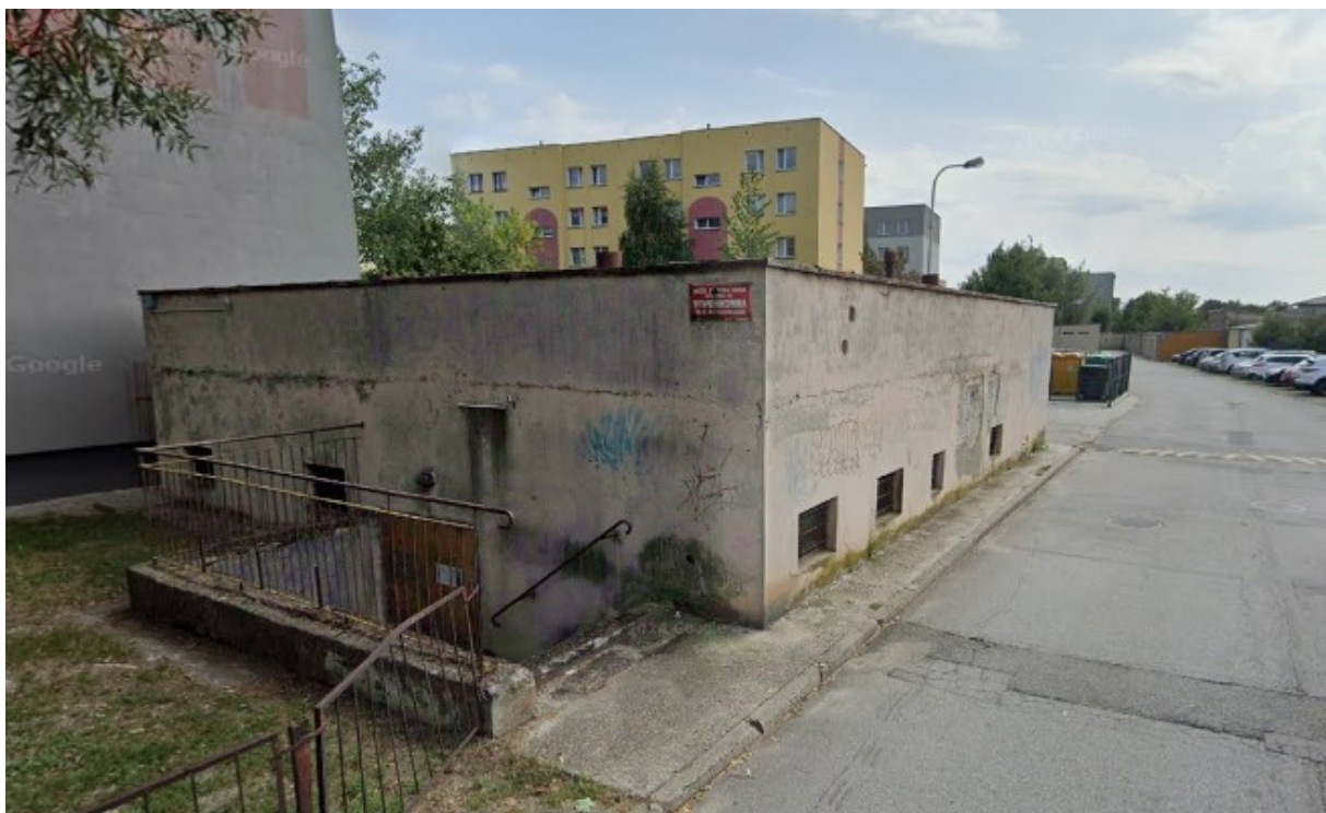
Widok budynku od strony północno zachodniej
